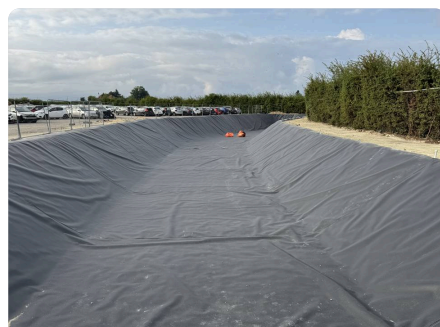
Bassin géomembrane en cours de réalisation
